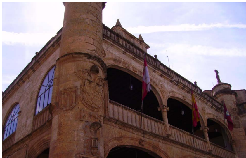
Las oficinas del Ayuntamiento se encuentran en los pisos superiores pero no hay ascensores para acceder a ellas.
